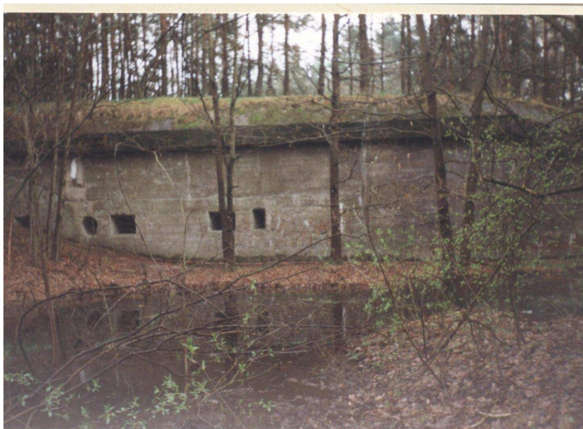
8.12. Umocnienia carskiego Fort V zbudowanego na przełomie XIX XX wieku wśród zalesień dokonanych przez Wojsko Polskie w latach trzydziestych XX wieku
