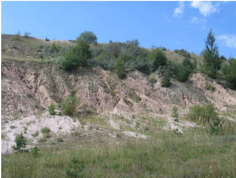
8.22. Nadleśnictwo Bełchatów. Zerodowane zbocza zalesionego magazynu gipsu położonego na nakładzie kopalni węgla brunatnego
